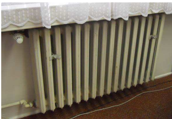
Obr. 17 a 18: Interiér kanceláře, (litinové žebrová otopná těleso, otopné deskové těleso - 5.NP)
