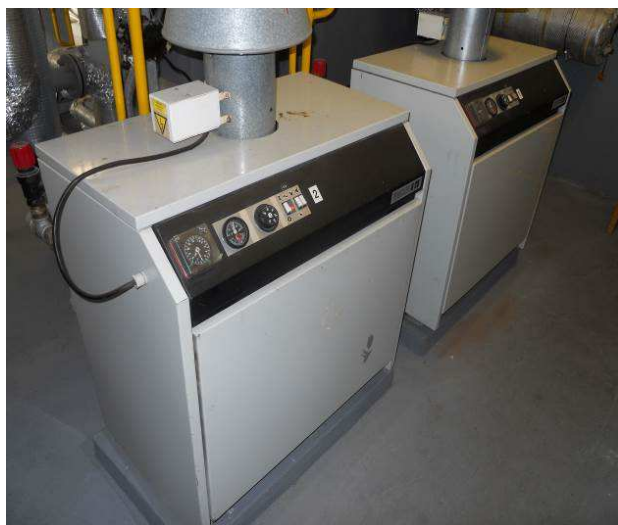
Obr. 9 a 10: Zdroje tepla pro vytápění – čtyři atmosferické kotle (3x VIADRUS G 25 – 43,75 kW, 1x VIADRUS G 27 – 45,0 kW)
