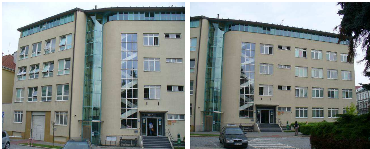
Obr. 2 a 3: Pohled od východu – budova B
