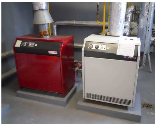
Obr. 9 a 10: Zdroje tepla pro vytápění – čtyři atmosferické kotle (3x VIADRUS G 25 – 43,75 kW, 1x VIADRUS G 27 – 45,0 kW)
