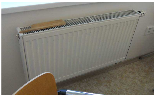
Obr. 17 a 18: Interiér kanceláře, (litinové žebrová otopná těleso, otopné deskové těleso - 5.NP)
