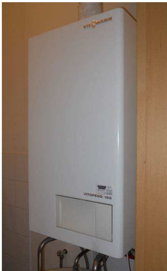
Obr. 11 a 12: Zdroje tepla pro vytápění 5.NP– dva plynové kotle (2x Vitopend 100 – 24 kW)
