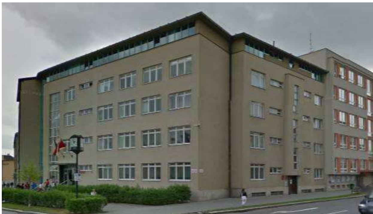
Obr. 1: Pohled od severovýchodu na budovy B a D
