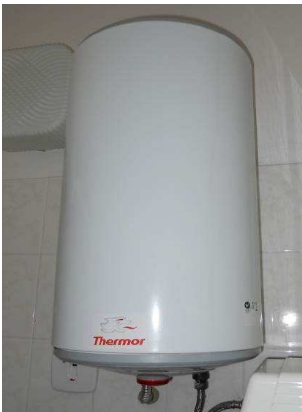
Obr. 13, 14, 15 a 16: Zdroje tepla pro ohřev teplé vody – stávající zásobníkové ohřivače vody
