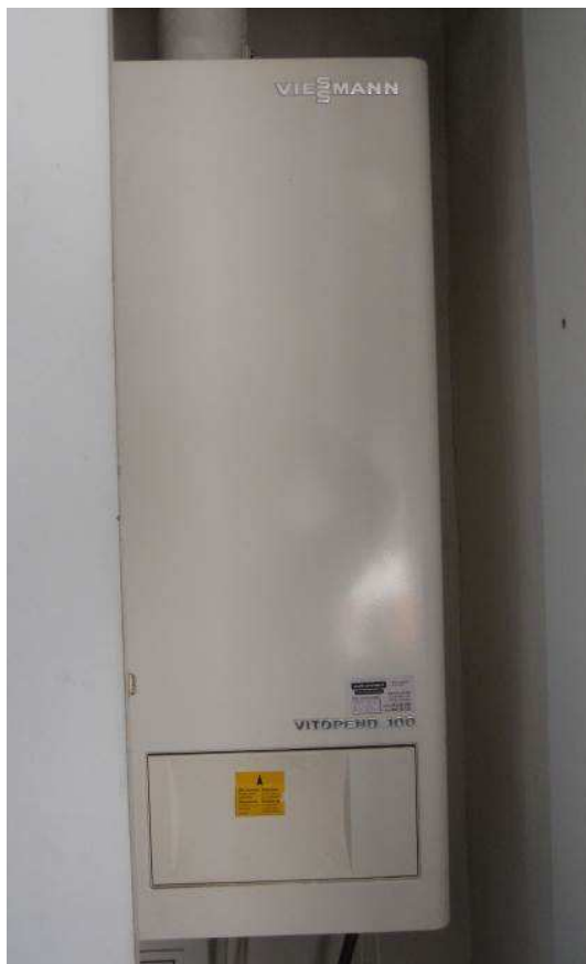
Obr. 11 a 12: Zdroje tepla pro vytápění 5.NP– dva plynové kotle (2x Vitopend 100 – 24 kW)
